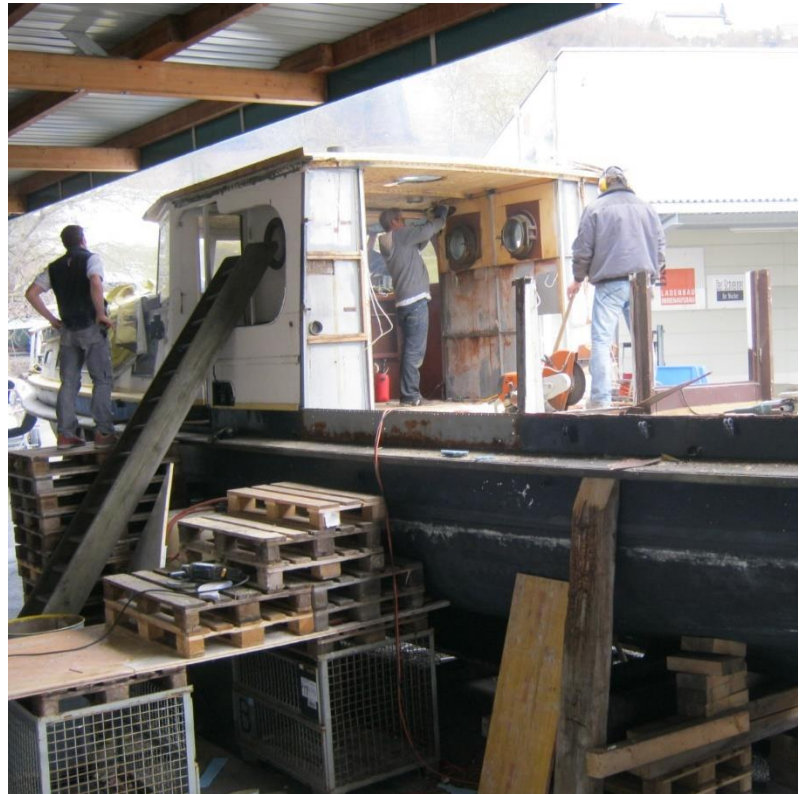
2011 | Der gesamte Aufbau sowie die Technik wurde bei der M. Müller Haustechnik AG demontiert
